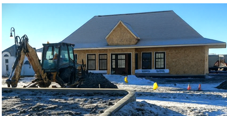
Réplique de la gare de Biggar en construction à la place Brownlee (2025)
